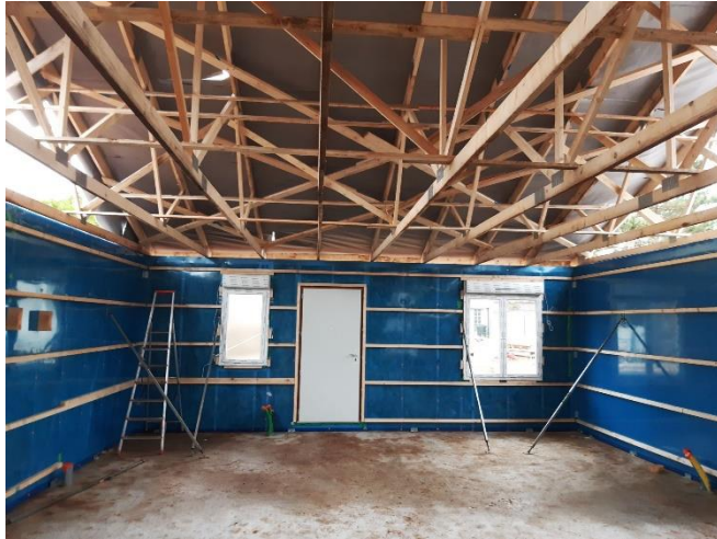
Anlieferung und Einbau der Wände
