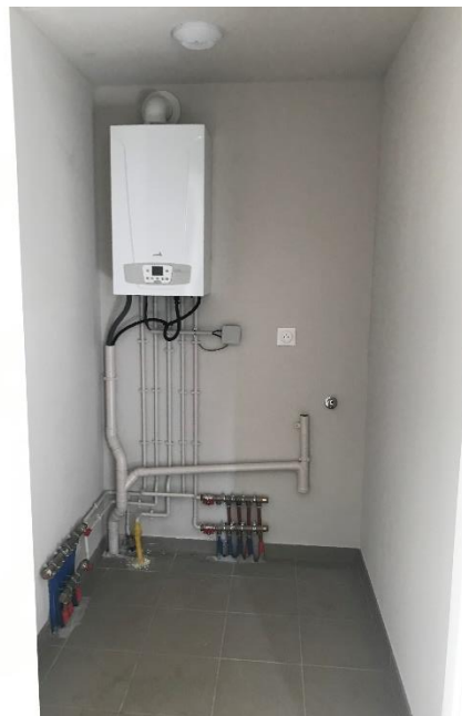
Kellerraum mit Heizkessel
