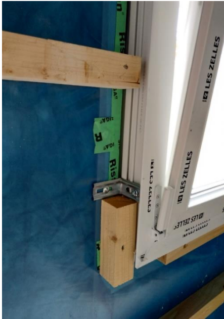
Details Abdichtung und Befestigungen
