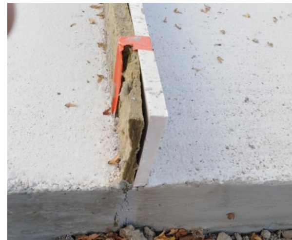
Dehnfuge, thermische Barriere
