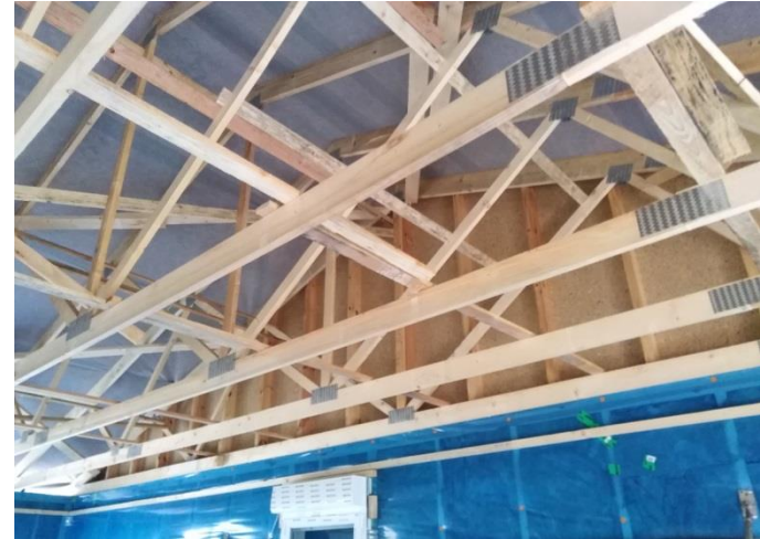
Einbau des Dachstuhls
