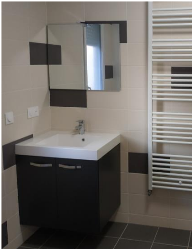
Abnehmbarer Waschtisch-Unterschrank mit Waschtisch auf Konsolhalterung und extraflachem Geruchsverschluss
