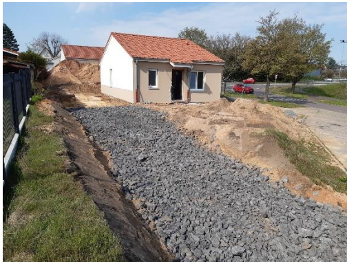
Fundamente der Fertiggaragen
