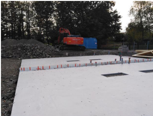
Gießen der Bodenplatten
