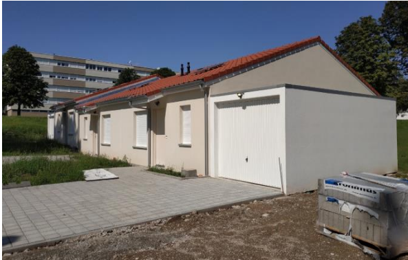
Einbau Garagen – Herstellung Fußweg und Stellplatz – Mutterboden - Anlegen von Rasen
