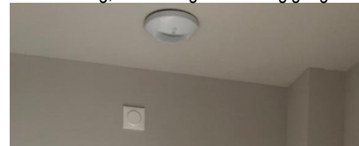
Abluftöffnung, luftfeuchtigkeitsabhängig regelbar
