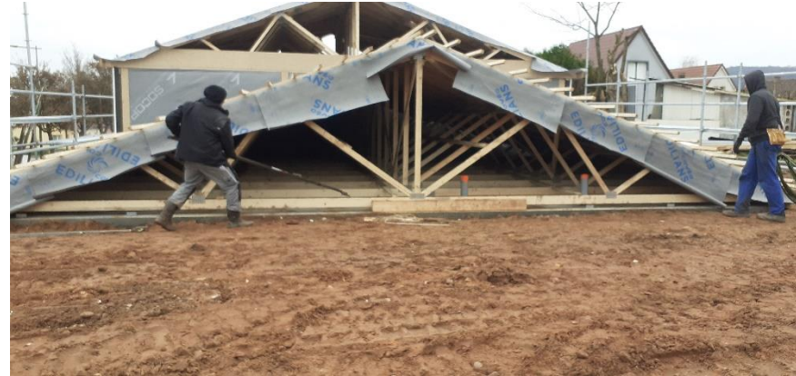
Montage des Dachstuhls aus Holz
