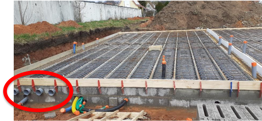
Dehnfuge, thermische Barriere
