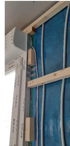
Detail Befestigung PVC-Fenster
