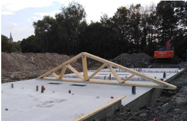
Anlieferung Dachstuhl aus Holz
