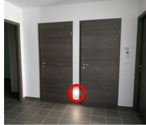
Beleuchteter Weg (nachts) zwischen Zimmern, Sanitärräumen und Eingang Zentrale Heizungssteuerung
