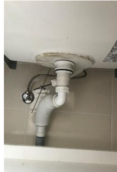
Abnehmbarer Waschtisch-Unterschrank mit Waschtisch auf Konsolhalterung und extraflachem Geruchsverschluss
