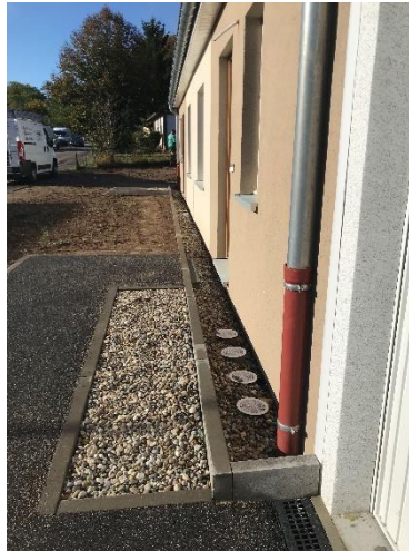
Kiesstreifen und Luftleitung Belüftungshohlraum
