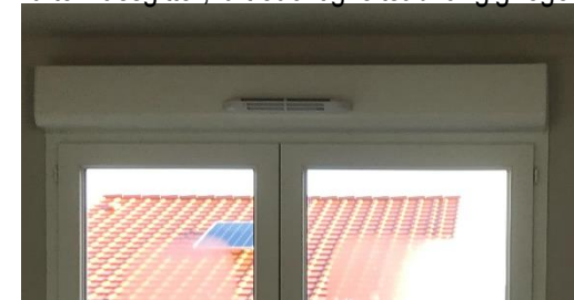
Abluftöffnung, luftfeuchtigkeitsabhängig regelbar
