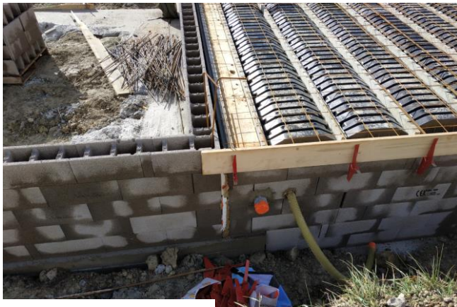
Vorbereitung Bodenplatte auf Belüftungshohlraum
