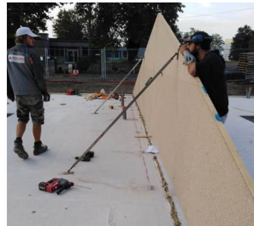
Vorbereitung Einbau Trennwände
