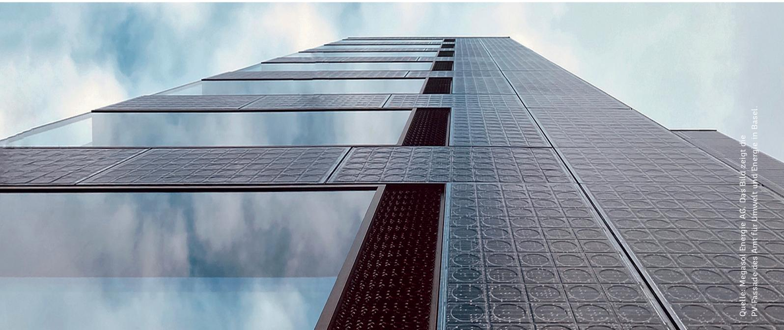
Quelle: Megasclo, Energie AG. Das Bild zeigt die PV-Fassade des Amis für Umwelt und Energie in Basel.
