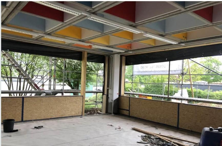
Fassade mit Mineralwolldämmung 240mm WLG 035
