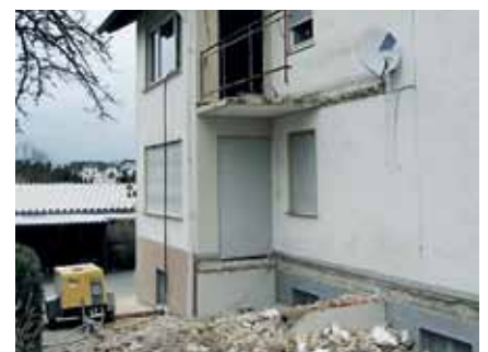
Abb. 55: Abbruch von Stahlbetonplatten zur Wärmebrückenvermeidung
