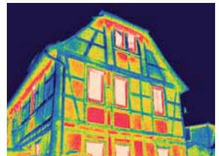
Abb. 22: Thermografieaufnahme eines Fachwerkhäuses. Das erkennbare Fachwerk wird bei der U-Wert-Berechnung flächenanteilig berücksichtigt.
