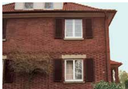
Abb. 8: Backsteinfassade mit sichtbarem Fenstersturz aus Beton
