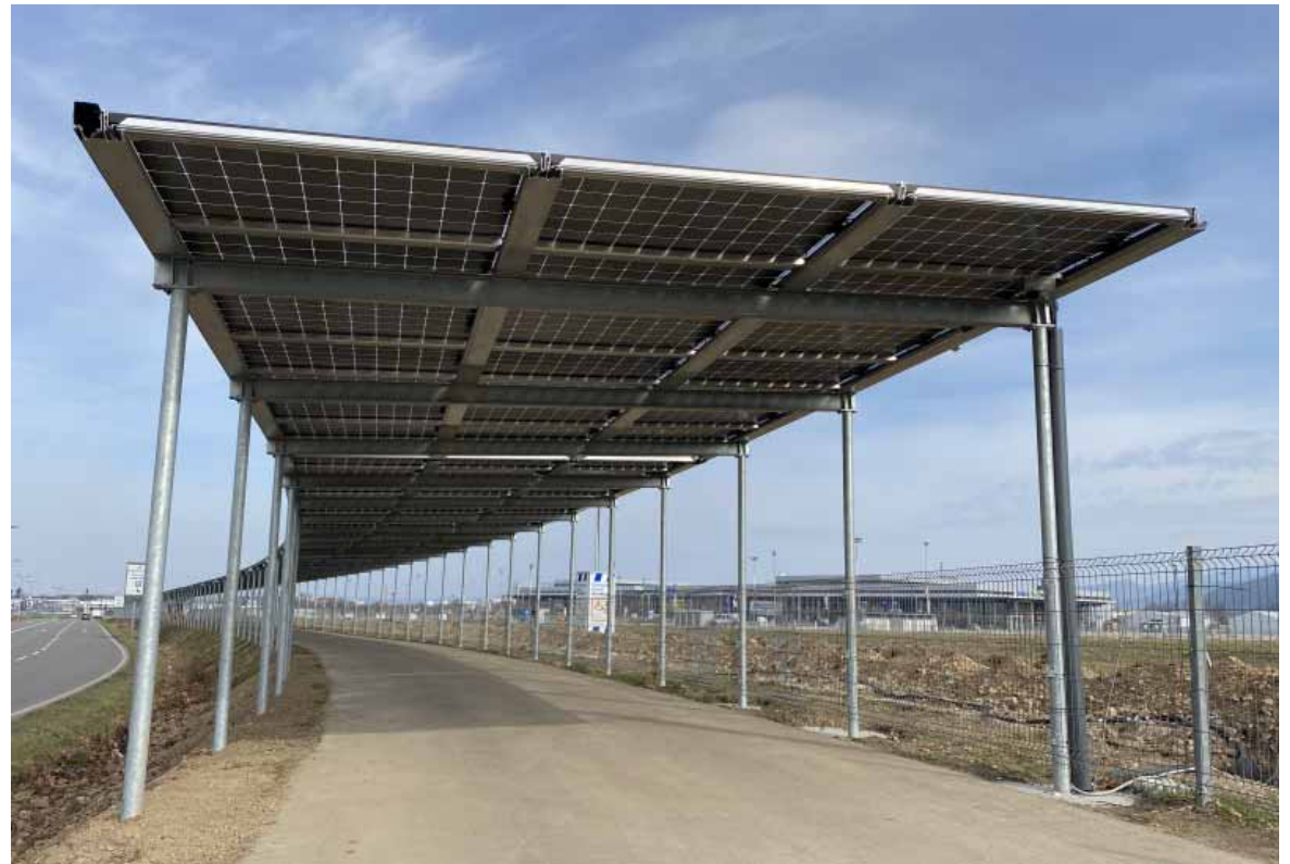
PV-Dach über Radweg, Freiburg
