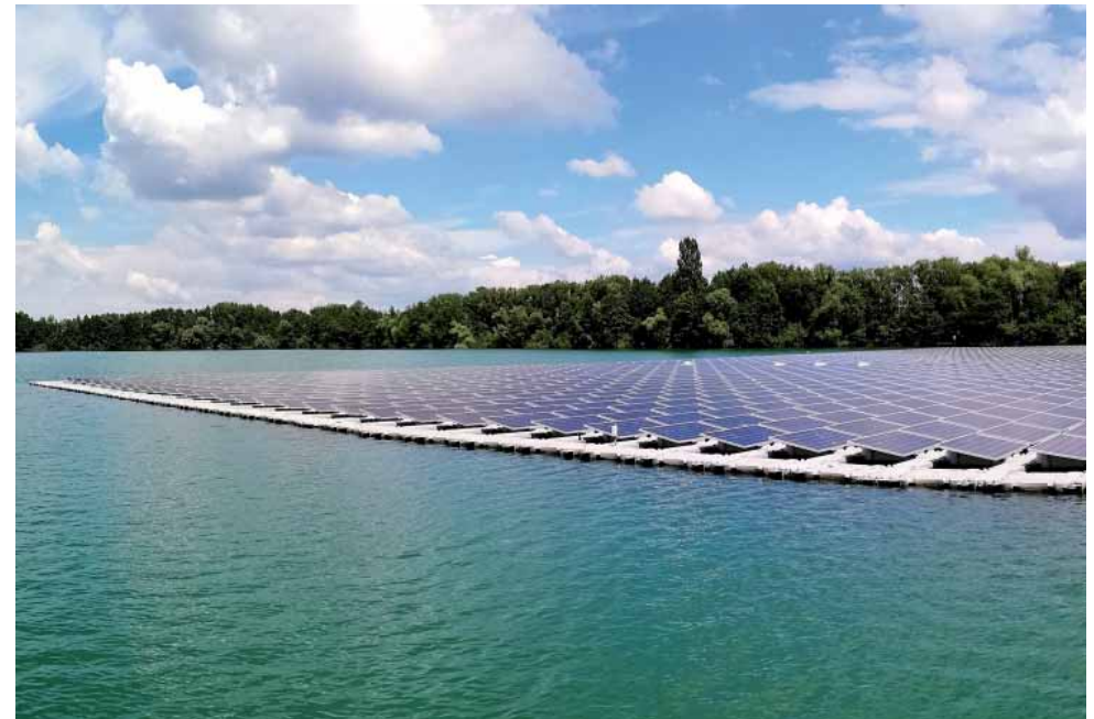
Schwimmende 750 kW PV-Anlage in Renchen auf dem Baggersee Maiwald
