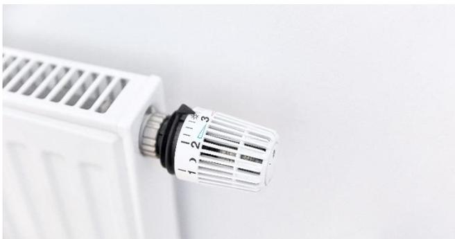
Abbildung 2: Über das Thermostatventil wird die Raumtemperatur reguliert. © shutterstock /Robert Kneschke
