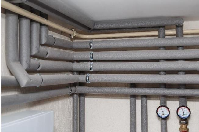
Abbildung 1: Wenig Aufwand, große Wirkung: Es lohnt sich Warmwasser- und Heizungsrohre zu dämmen.
