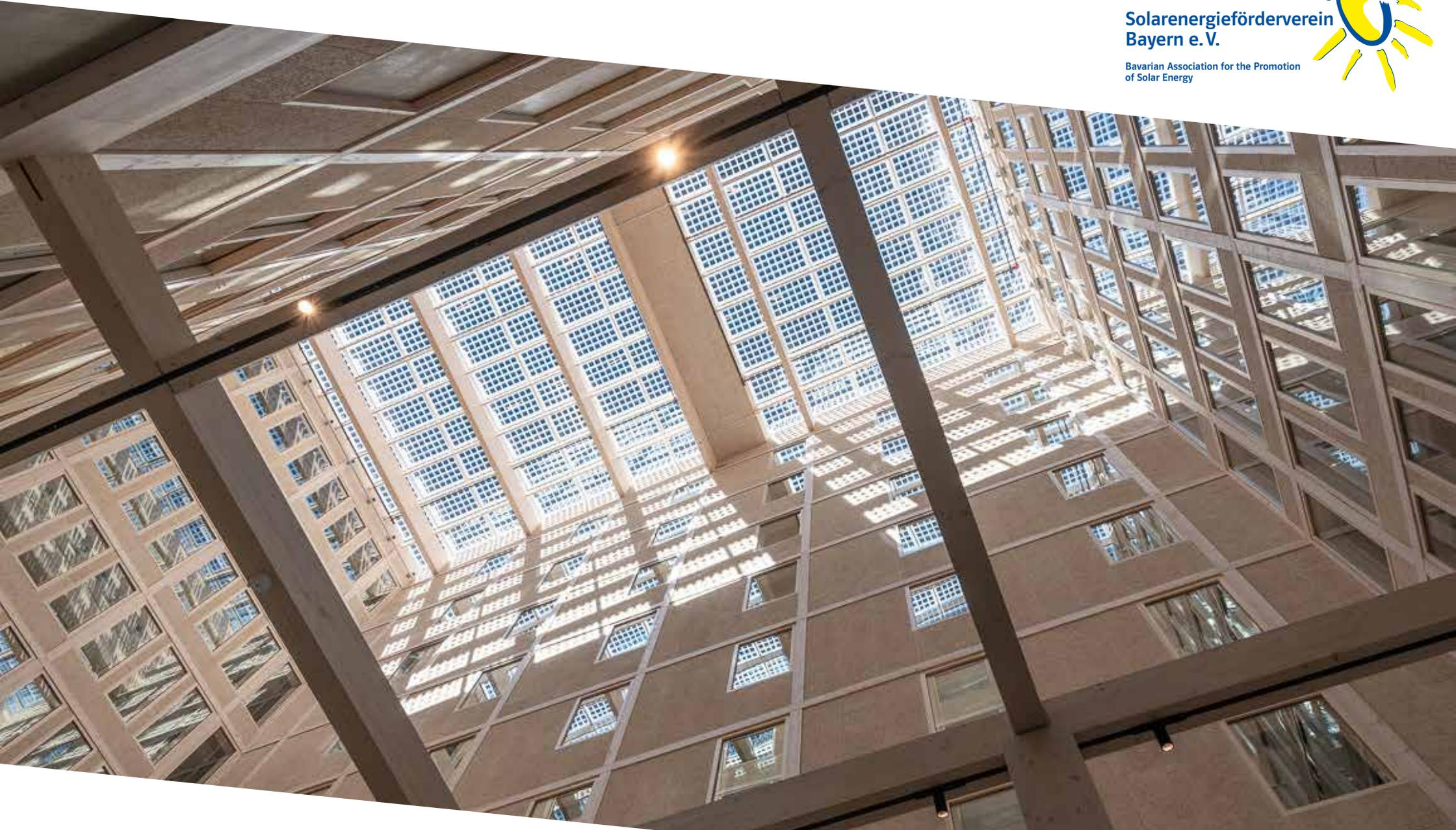
97,02 kW PV, davon fast 70 kW an der Fassade (O-S-W)
