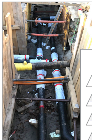
Verlegung von Wärmeleitungen
