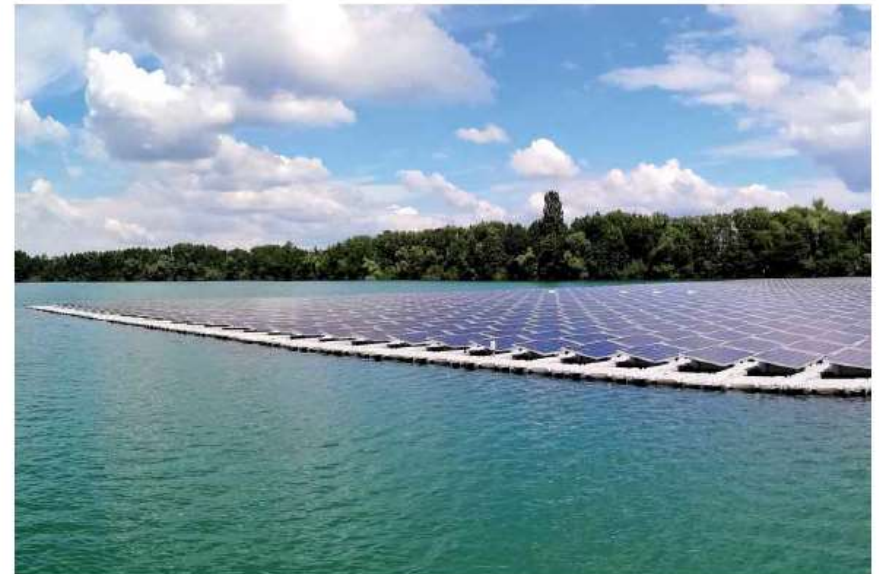
Schwimmende 750 kW PV-Anlage in Renchen auf dem Baggersee Maiwald
