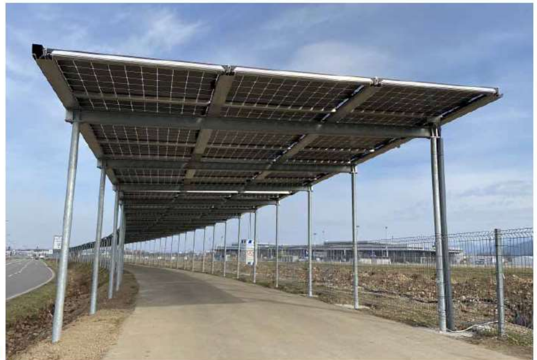
PV-Dach über Radweg, Freiburg
